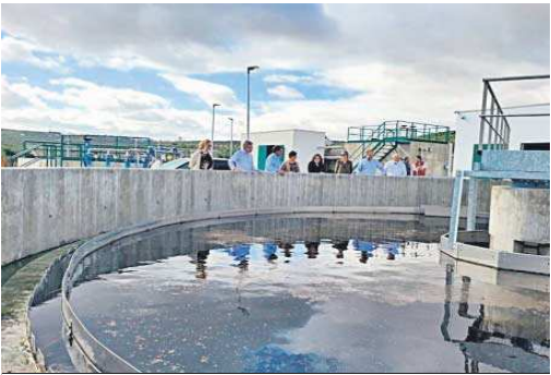
Estación Depuradora de Aguas Residuales en Sevilla.
